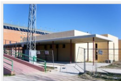
Vista actual de las aulas de Nueva Segovia anejas al pabellón Pedro Delgado / EL NORTE
